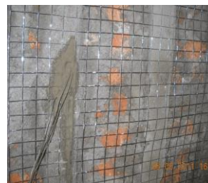
(d) pemasangan kawat pada dinding bata
