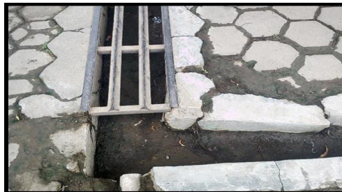
Gambar 11 Drainase MAN 2 Padang Ukuran Lebar 25 cm dan Tinggi 40 cm
