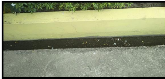
Gambar 9 Drainase MTSN 6 Padang Ukuran Lebar 22 cm dan Tinggi 37 cm
