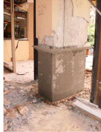
(d) setelah perbaikan dan perkuatan
