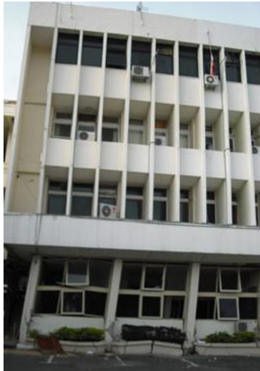
Gambar 4. Kegagalan pondasi diakibat efek liquifaksi
