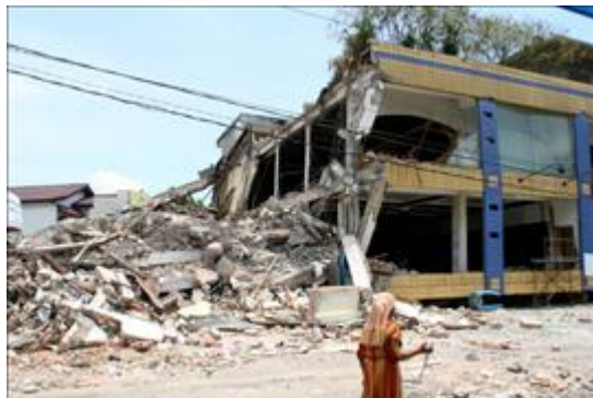
Gambar 5. Keruntuhan akibat kualitas material yang tidak memenuhi persyaratan
