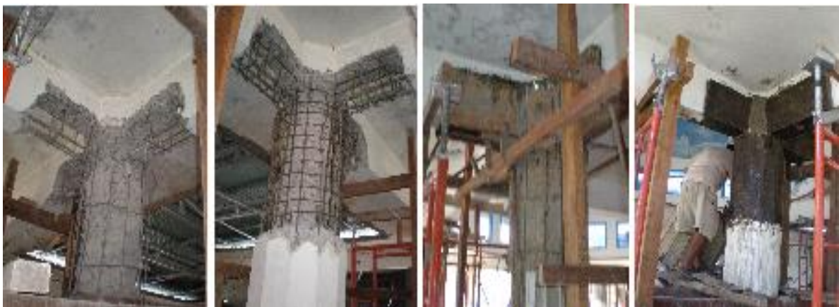
Gambar 9. Proses perbaikan dan perkuatan kolom rusak pada bagian bawah
