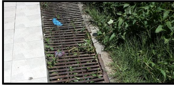
Gambar 7 Drainase MIN 3 Padang Ukuran Lebar 32 cm dan Tinggi 7 cm
