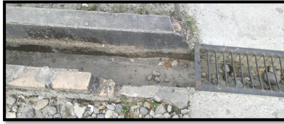
Gambar 7 Drainase MIN 3 Padang Ukuran Lebar 32 cm dan Tinggi 7 cm
