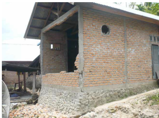
Gambar 8. Sebagian dinding bata roboh
