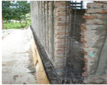
Gambar 12. Perbaikan dan perkuatan bangunan non-engineered dengan penambahan tulangan sloof, kolom dan ring balok
