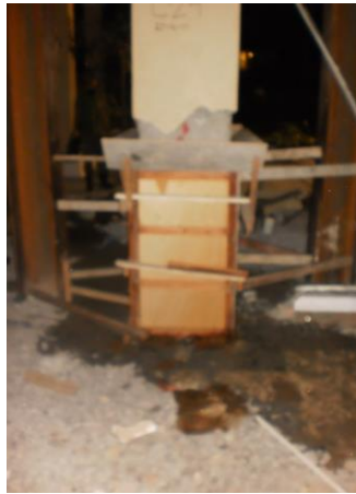
(e) bekisting dan cor beton
