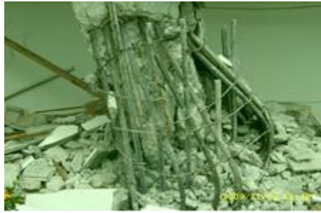
Gambar 2. Detailing penulangan geser yang tidak sesuai standard.
