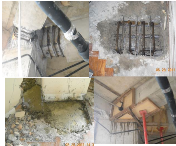
Gambar 11. Proses perbaikan dan perkuatan balok
