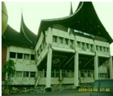
Gambar 3. Efek soft-story pada bangunan
