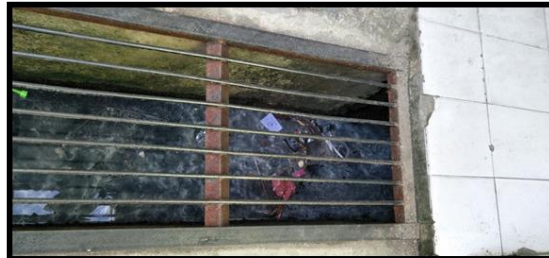
Gambar 10 Drainase MTSN 6 Padang Ukuran Lebar 55 cm dan Tinggi 35 cm
